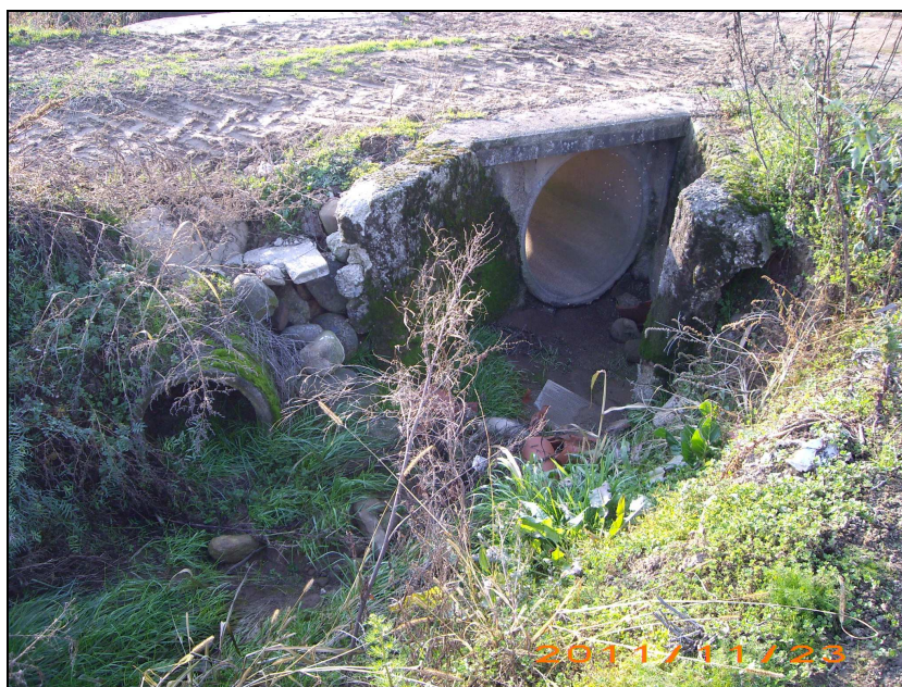
FIG.36 Particolare roggia n.3 attraversamento agricolo
