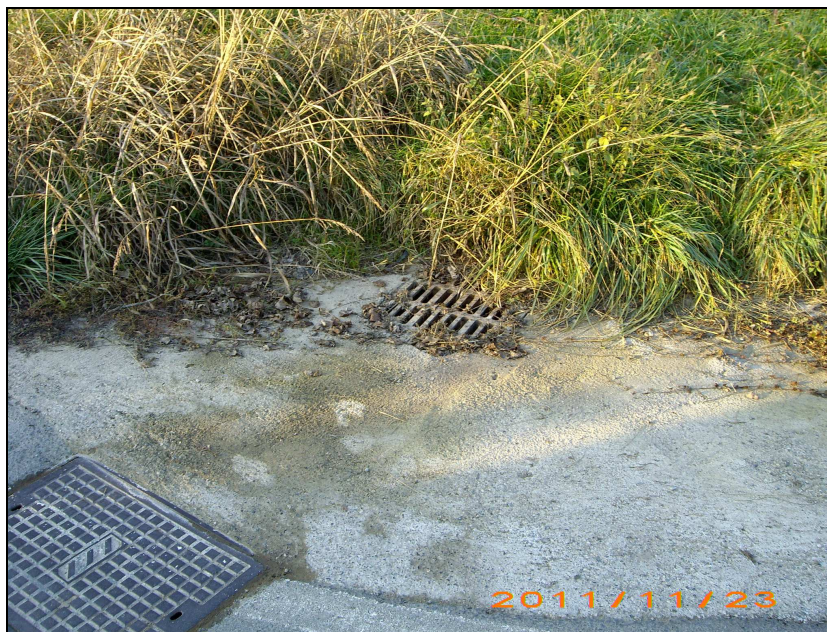
FIG.52 Particolare Roggia n.2 griglia con tombamento su via Fontanella
