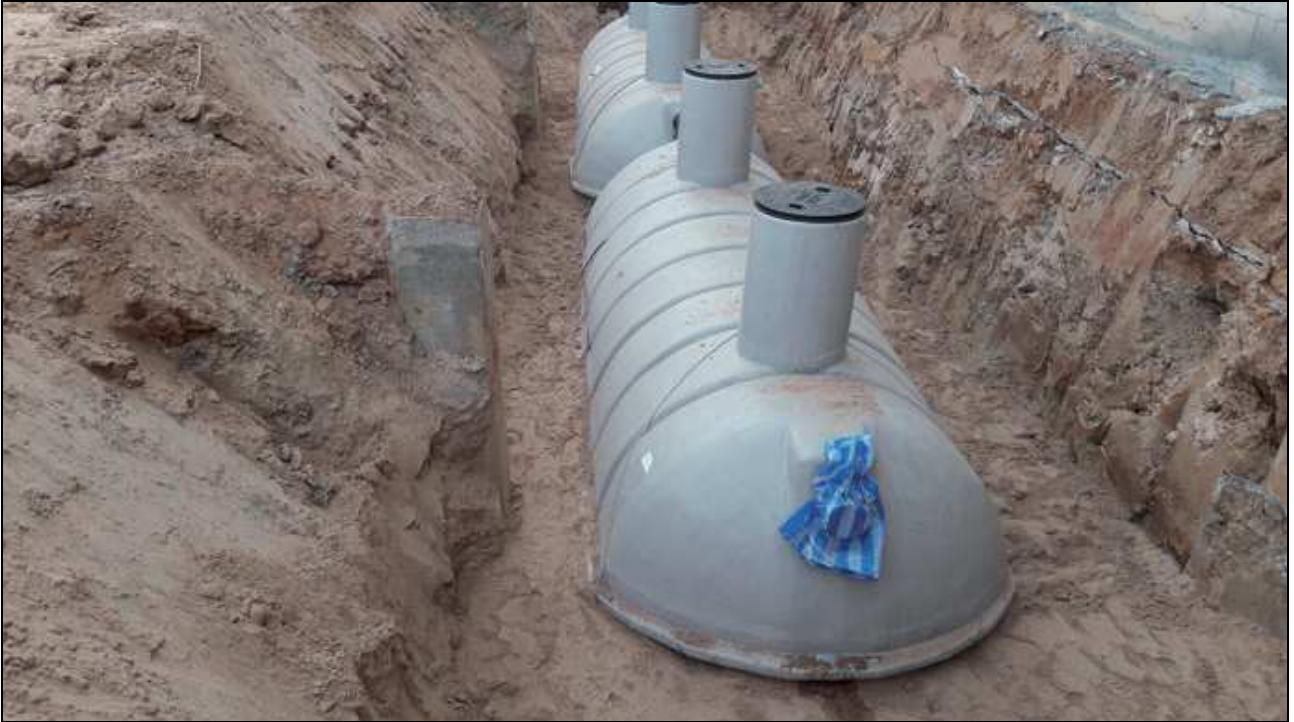
FIG. 125 Esempio di Cisterna interrata
