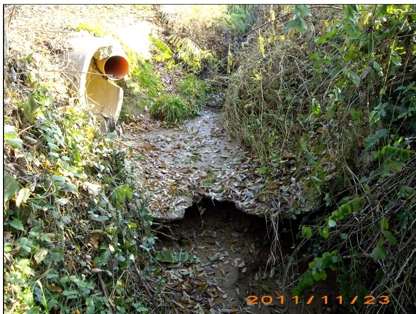
FIG.32 Particolare roggia n.3 alveo in approfondimento con uscita tubazione diam. 800 mm da proprietà Galbusera
