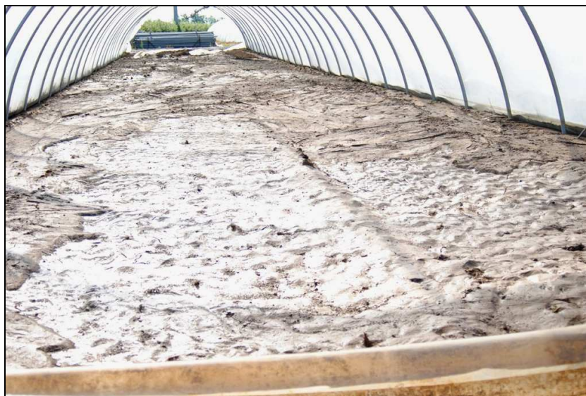
FIG.106 Sovralluvionamento in serra con accumulo di materiale limoso argilloso
