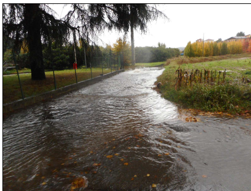
Fig. 118 Allagamenti per rigurgito Collettore Fognario presso isola Ecologica
