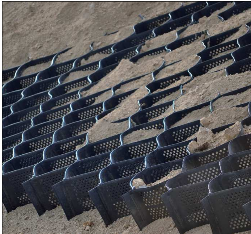
FIG. 126 Esempio di Sistemi modulari geocellulari
