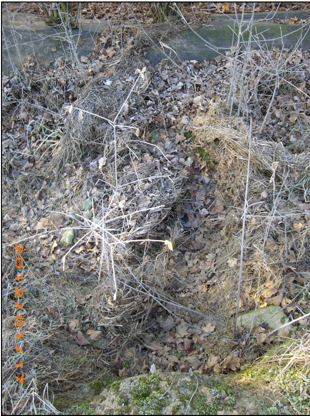
FIG.81 Particolare scarpata con tracce di ruscellamento Prop. Ancarari
