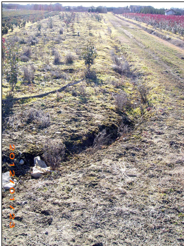
FIG.71 Particolare canale a nord di Moscoretto
