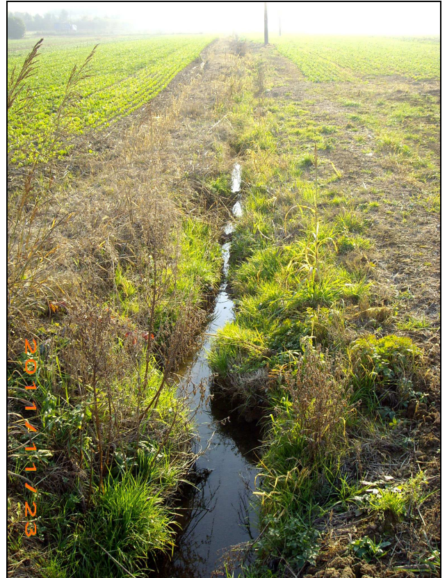
FIG.59 Particolare roggia n.2
