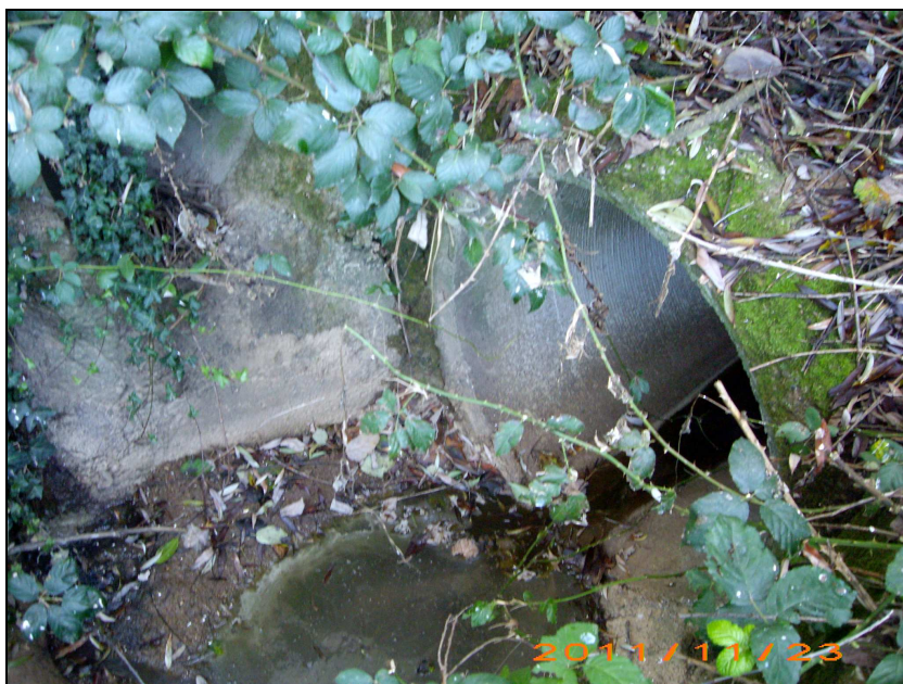
FIG.29 Particolare roggia n.3 ingresso tombamento
