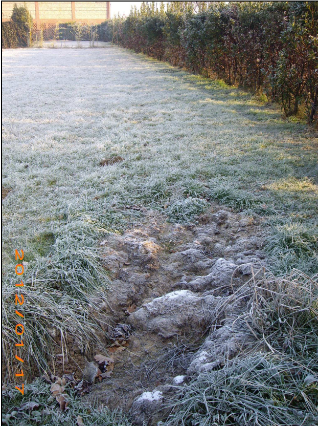
FIG.87 Particolare testata canale all'interno della proprietà Ancarani
