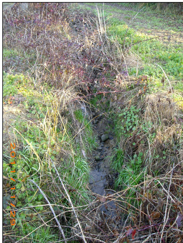
FIG.38 Particolare roggia n.3
