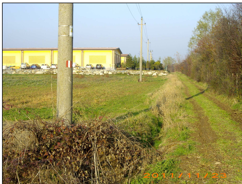
FIG.55 Particolare roggia n.2 adiacente alla carrareccia confinante con proprietà Ancarani
