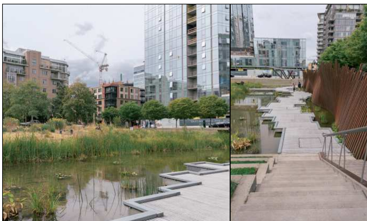
FIG. 128 Esempio di Bacino di infiltrazione
