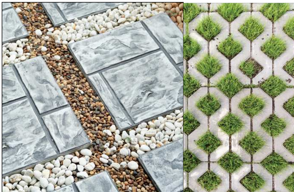
FIG. 127 Esempio di Pavimentazione drenante
