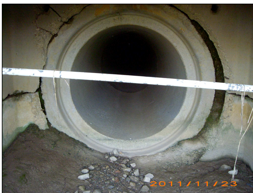
FIG.33 Particolare roggia n.3 ingresso tombamento
